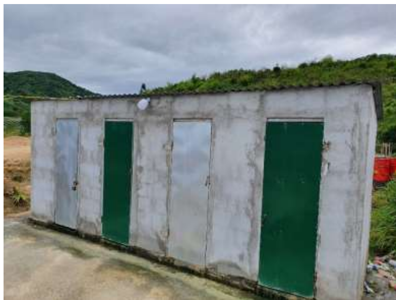
Hình 6. Nhà vệ sinh (kết cấu bằng bê tông cốt thép 3 ngăn)
